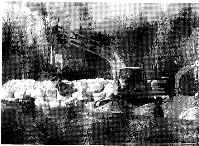
掘削作業に追われる造成地
